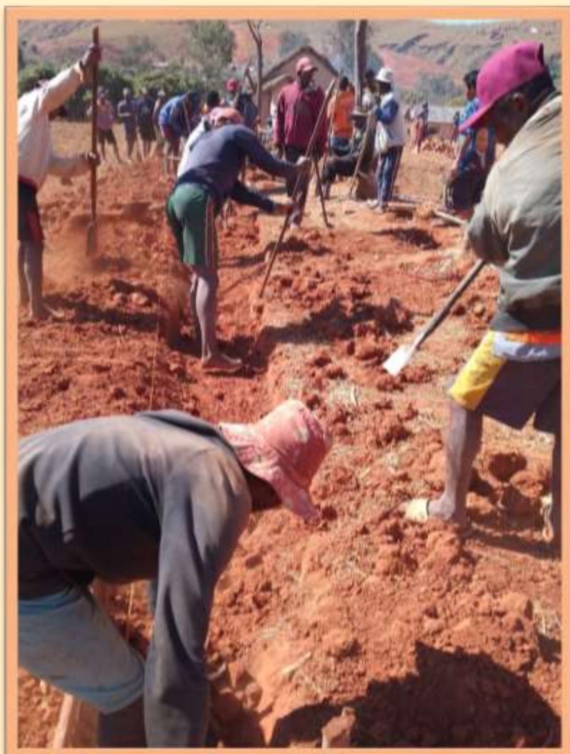
Lorsque les familles savent que le montant est complété pour la construction de la future école; vite les mesures sont prises et les familles stabilisent le sol avec leur instrument de labour traditionnel. Ils préparent la fondation pour recevoir les moellons.
